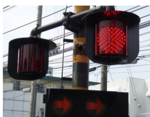
全方位式踏切閃光灯
