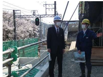
有馬線・花山駅新駅舎工事現場
