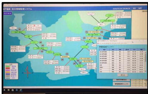
防災情報監視システムの監視画面（PC上）
