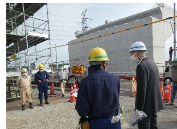
受託工事現場 (榎山駅～市場駅間)
