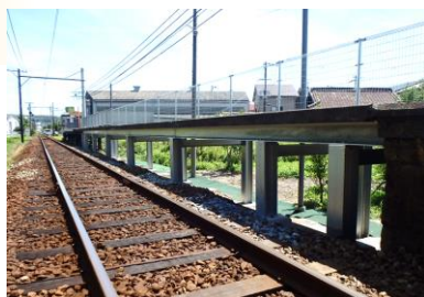
ホーム下部工取替 （大村駅）
