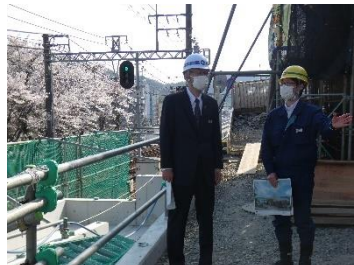
有馬線・花山駅新駅舎工事現場
