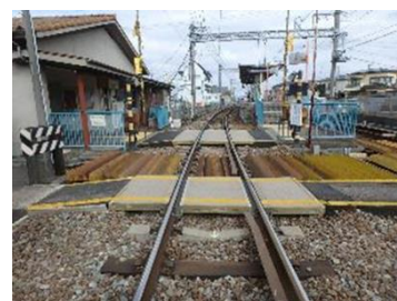
広野ゴルフ場前駅構内 PC まくらぎ化工事
