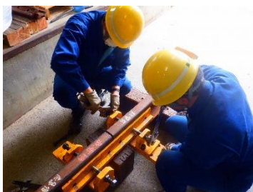
レール折損応急復旧訓練
