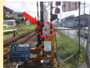
上通池第1踏切道
