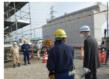
受託工事現場 (榎山駅～市場駅間)
